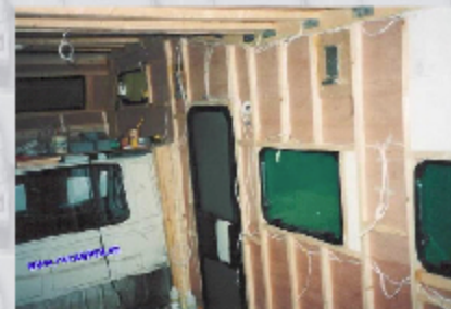
Aanbrengen ramen, deur en kabels
