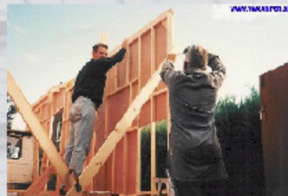
De opbouw (eerste fase)
