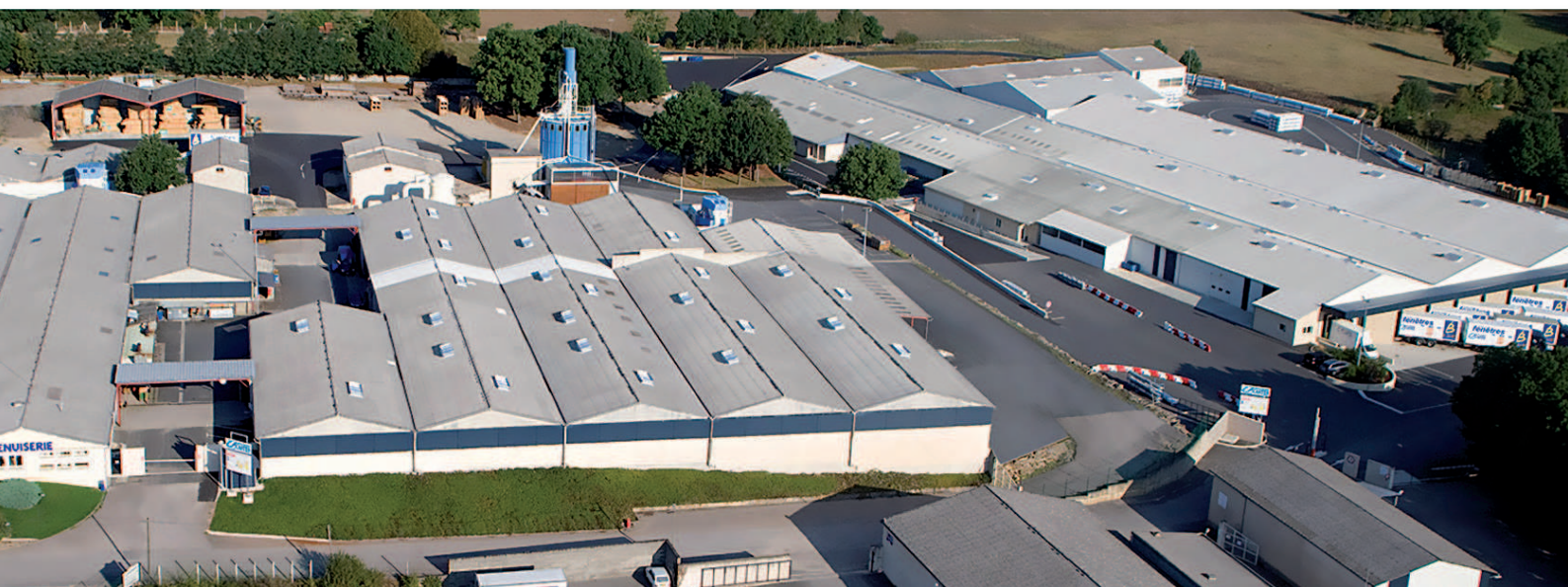
Vue aérienne de l'usine à Villefranche-de-Rouergue (Aveyron)
