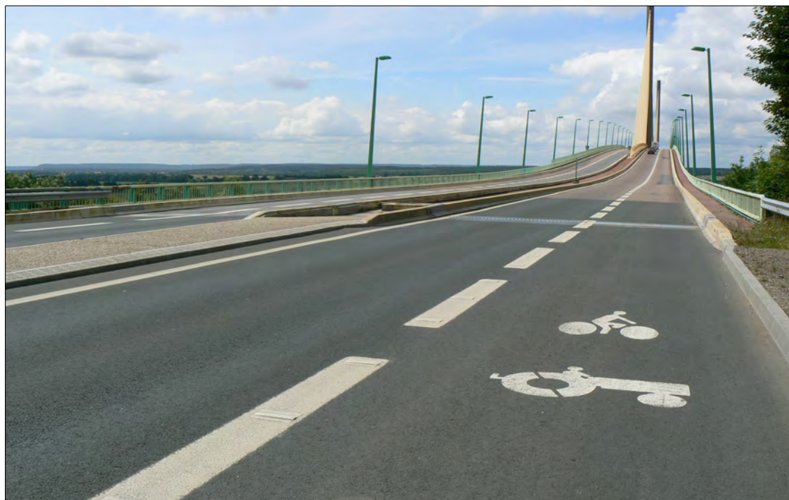
Illustration 7 : RD490 - Pont de Brotonne - Réalisation d'une voie mixte engins agricoles et vélos (Source : Cerema Normandie-Centre, 2013)
