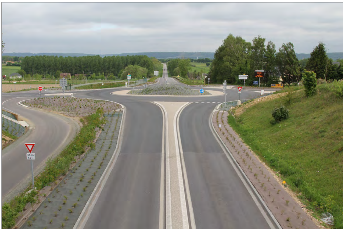
Illustration 3 : Intersection RD490/RD131 : réalisation d'un giratoire et de contre-allées permettant le rétablissement d'intersections supprimées (Source : Cerema Normandie-Centre, 2014)
