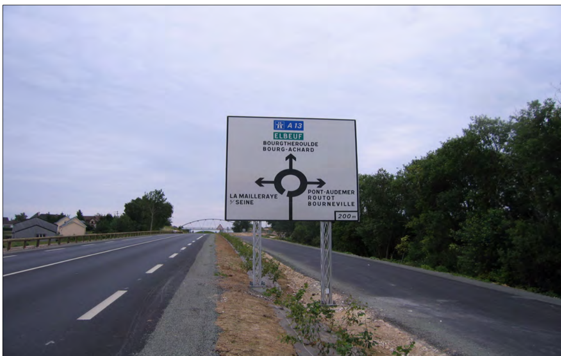
Illustration 16 : Support de signalisation à sécurité passive (Source Cerema Normandie-Centre, 2014)
