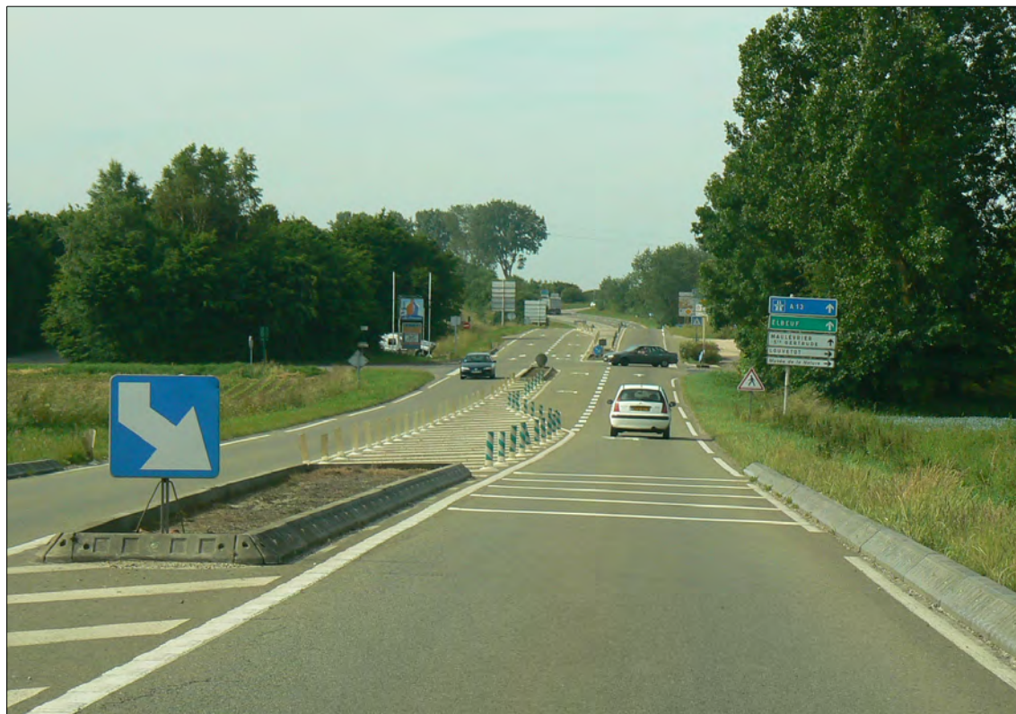
Illustration 5 : Intersection RD131/RD33 : aménagement sous forme provisoire de l'intersection à l'aide de modules démontables (Source : Cerema Normandie-Centre, 2011)
