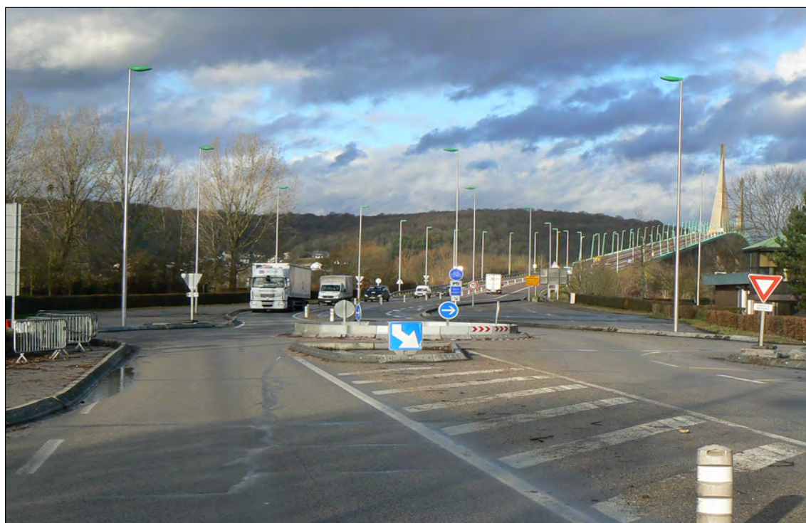
Illustration 6 : Intersection gare de péage : aménagement sous forme provisoire de l'intersection à l'aide de modules démontables (Source : Cerema Normandie-Centre, 2011)
