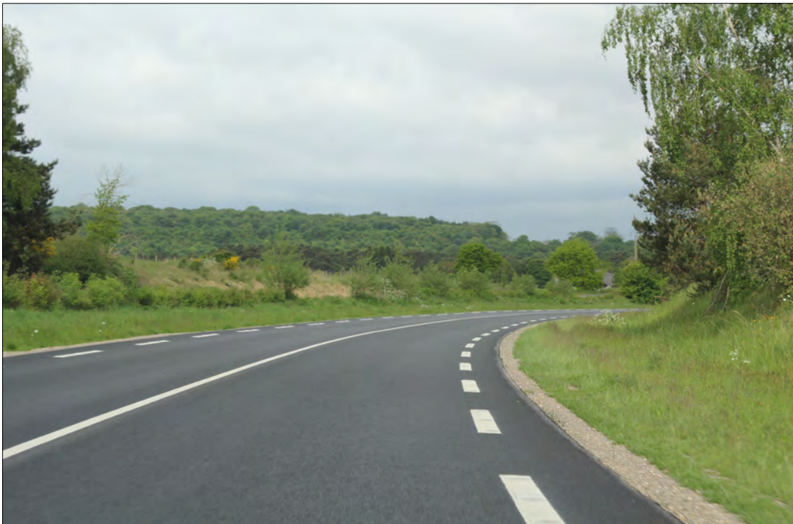
Illustration 11 : RD490 - Chaussée mono-déversée : réduction des largeurs de voies au profit d'une bande dérasée de droite avec bandes d'alerte sonore implantées en rive (Source : Cerema Normandie-Centre, 2014)
