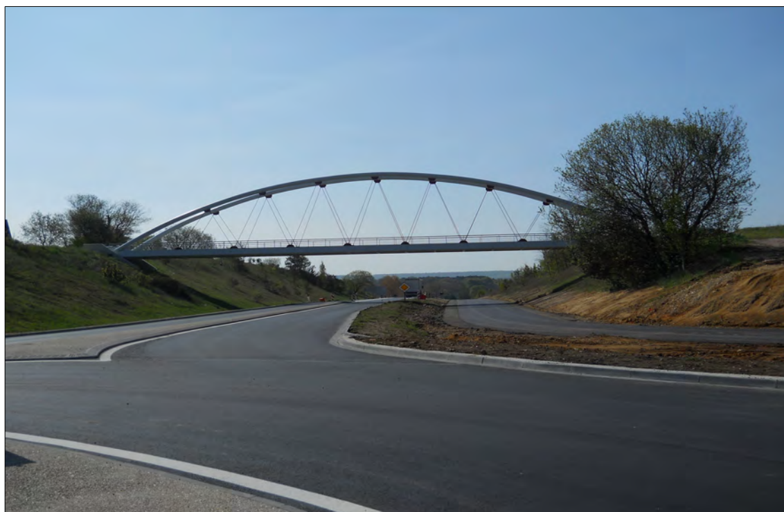
Illustration 8 : RD490 - Fermeture d'intersections et rétablissement via des contre-allées sur des intersections aménagées - Réalisation d'une passerelle piétonne (Source : Département de Seine-Maritime, 2013)
