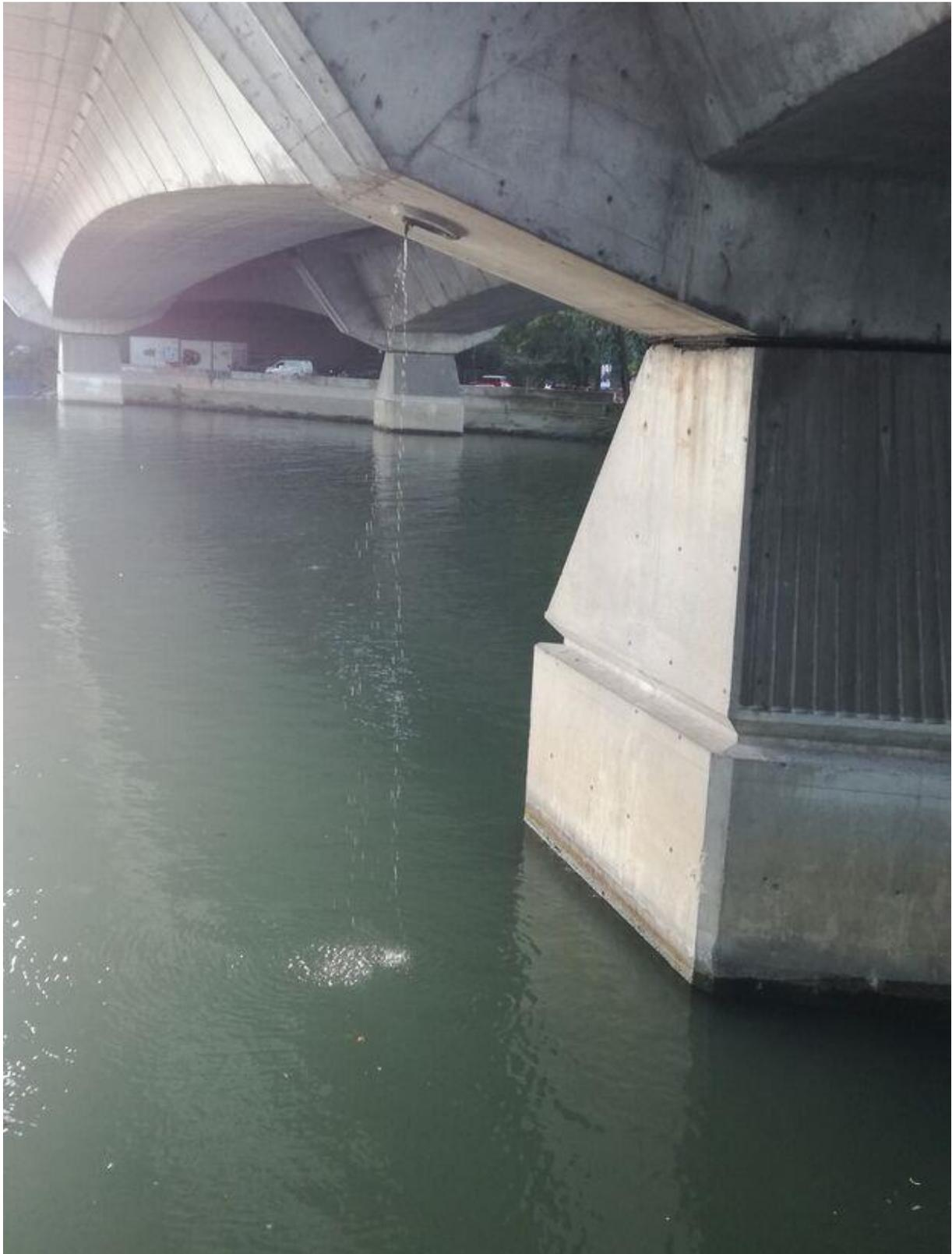
Sur le tronçon commun A4 - A86, l'autoroute le plus fréquentée de France avec 250 000 véhicules par jour, les eaux de pluie se chargent de polluants et ruissellent dans une rigole avant d'être déversées directement dans la Marne.
